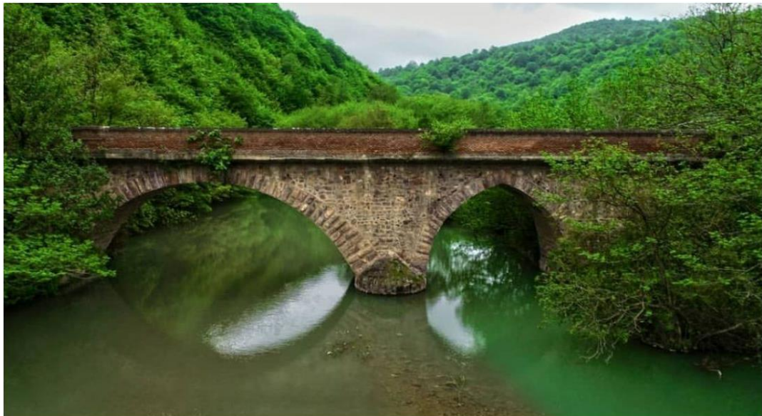
شکل شماره دو: پل سیاه رود رودبار، پایه‌های پل متعلق به عصر صفوی و بنای آن متعلق به دوره قاجار است.
